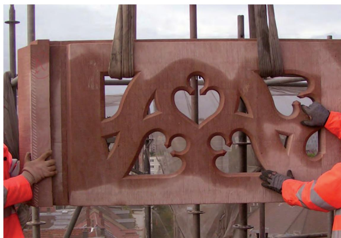
matik noch verstärkte. Viele der aufwändig gearbeiteten Maßwerke und Kreuzblumen wurden aus diesem stark auflagernden Naturwerkstein erstellt. Da die entstandenen Schäden erheblich waren, mussten etliche Bauteile bereits im Rahmen der Notsicherung abgenommen werden, um einen weiteren Substanzverlust zu vermeiden.
